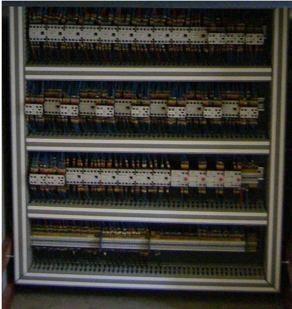
C'est cette platine qui contient tous les composants électriques nécessaires au bon fonctionnement du carrefour. C'est exactement cet équipement qui serait installé à l'intérieur de l'armoire de distribution que l'on appelle aussi armoire de commande ou encore armoire de séquence dans une installation « réelle ».
