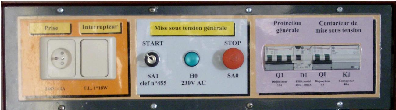
Cette vue représente le fronton de distribution électrique réalisé et utilisé sur chaque armoire didactique. Le principe de fonctionnement est identique pour toutes les armoires placées dans le local C14. Ce fronton sert principalement à isoler complètement l'installation du réseau. L'autorisation de mise sous tension ne pourra être réalisée que sous la supervision du professeur. Lui seul est habilité à mettre l'armoire sous tension, après avoir prit les mesures de sécurités nécessaires.
